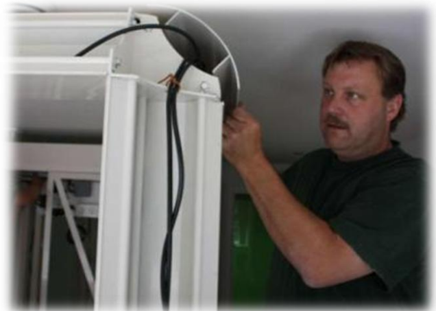
Elementen plaatsen, installatie aansluiten en de afdekkappen monteren
