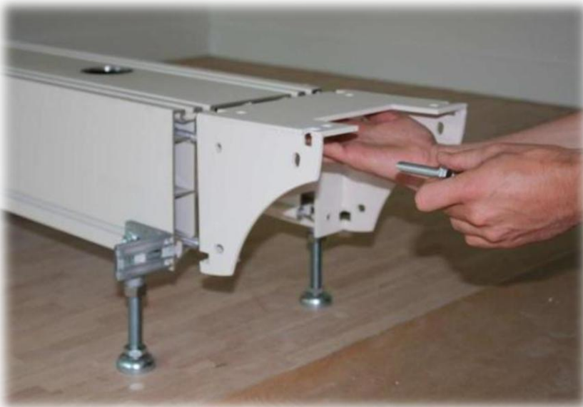
Start van het opbouw bij de rioolaansluiting (middenbalk)
