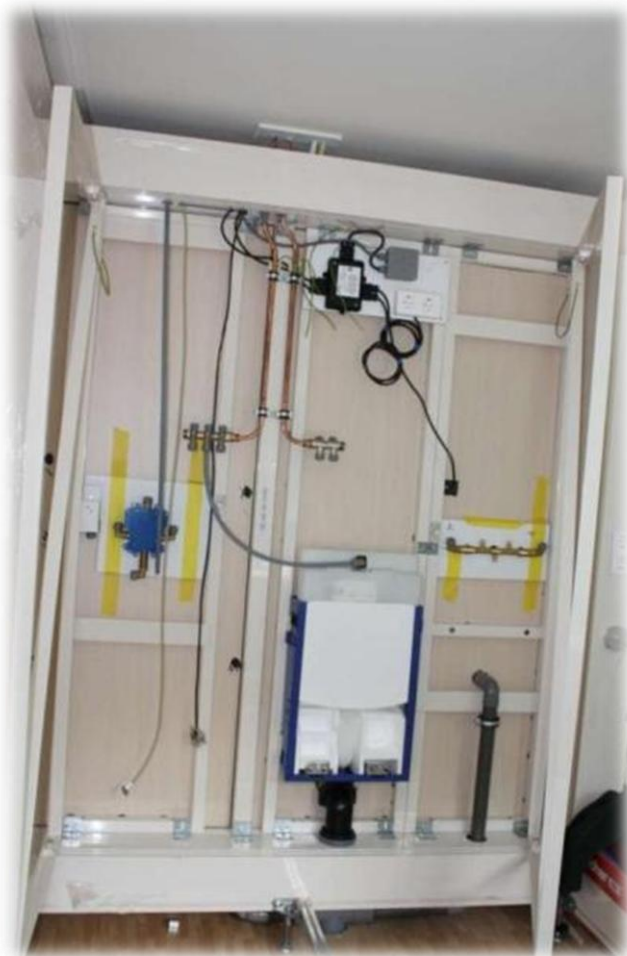
Elementen plaatsen, installatie aansluiten en de afdekkappen monteren
