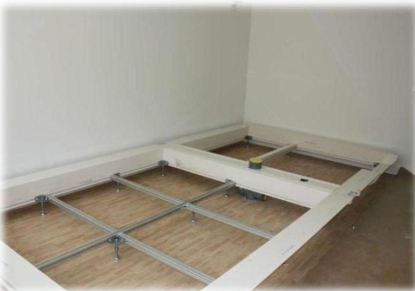
Opbouw van het onderframe
